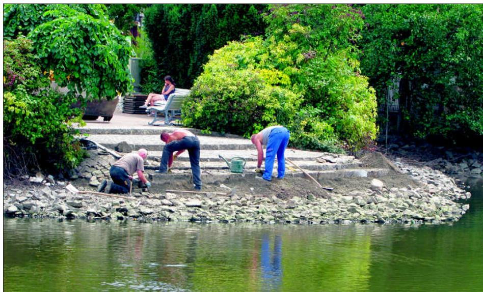
Durch das Absenken des Wasserspiegels gaben auch die Stufen zum Marktplatz nach. Arbeiter besserten die Schäden aber schnell wieder aus.
