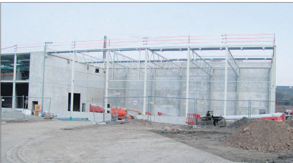
Eine neue Produktionshalle wird gegenwärtig von der Thyssen Krupp Presta Ilsenburg GmbH errichtet. Mindestens 130 neue Arbeitsplätze sollen hier ab Sommer entstehen.
