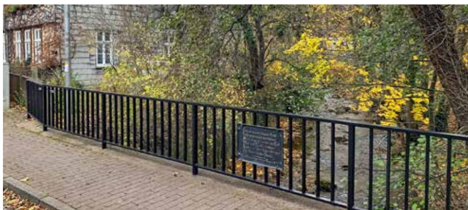
Die Malerfirma Peters aus Stapelburg hat im Auftrag der Stadt das Geländer der Pfarrbrücke neu gestrichen. In Kürze wird auch noch die Gedenktafel für die Opfer des Einsturzes der Brücke beim Hochwasser im Jahre 1859 überarbeitet.
