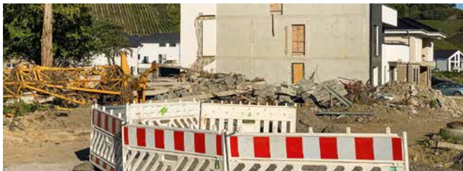
Zerstörte Brücken, Baumaschinen und Häuser an der Ahr
