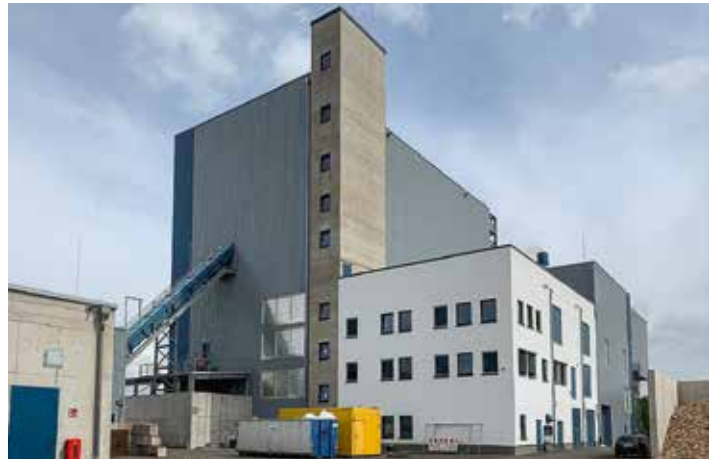
Das vergleichbare Biomasse Holzheizkraftwerk in Uetze bei Han- nover. In Ilsenburg würde der Kessel liegend errichtet werden, um die Gebäudehöhe zu reduzieren
