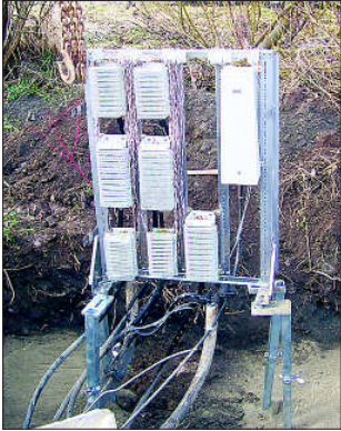
Neue DSL-Technik wurde in die Schaltschranke eingebaut.
