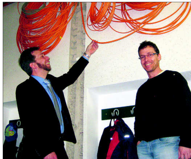
Bürgermeister Denis Loeffke (links) informierte sich bei Schulleiter Frank Martin über den Fortgang der Installationsarbeiten.
