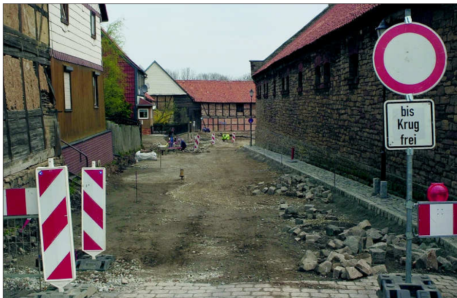
In der Drübecker Hauptstraße wird gegenwärtig emsig gearbeitet. Bis zum Ende des Monats Mai sollen die Arbeiten weitgehend abgeschlossen sein.
